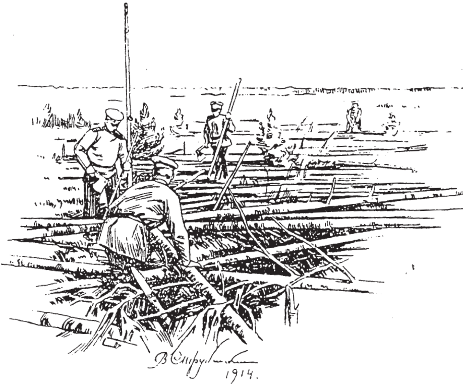
Piirrokset esittävät venäläisten sapöörijoukkojen kenttälinnoitustöitä vuonna 1914. Ylemmässä kuvassa kuljetetaan hiekkaa tai maata kottikärryjen avulla ja alemmässä kuvassa rakennetaan etenemisesteitä puolustusasemien etumaastossa. Piirrokset V. Strubinski
